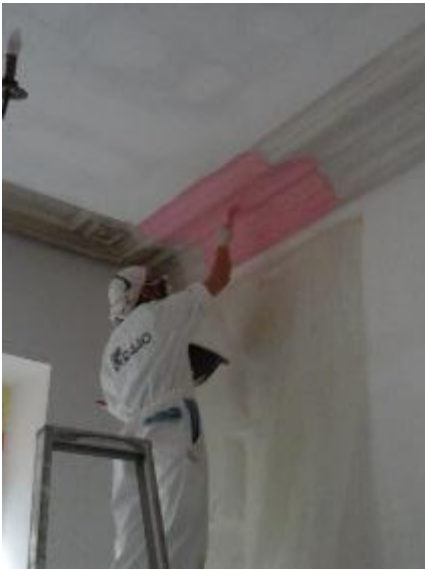
Réalisation d'un négatif de la moulure existante Source: Philippe Abel
