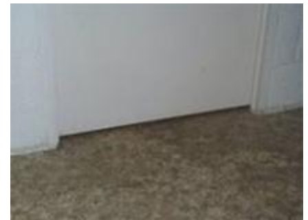
Porte détalonnée H_{\text{fente}} \geq 5 \text{ mm}
