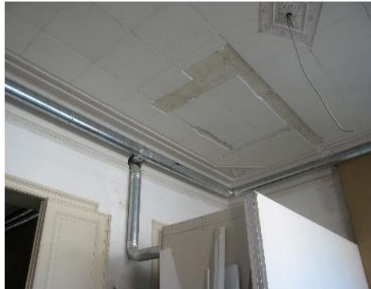
Installation des gaines de ventilation Source: Philippe Abel
