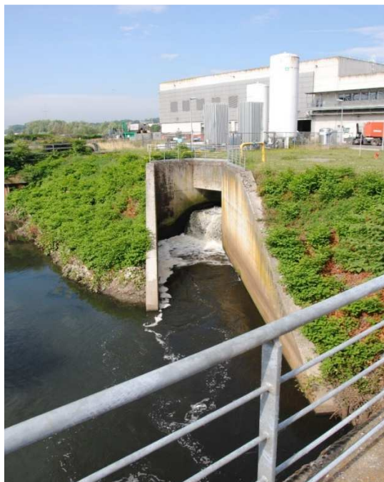
Déversement des eaux usées dans la Senne, après traitement par la station d'épuration de Bruxelles-Nord.
