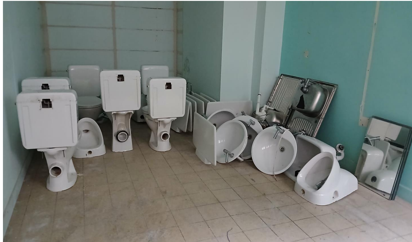
Appareils sanitaires, miroirs,... qui seront réutilisés lors de la rénovation du bâtiment
