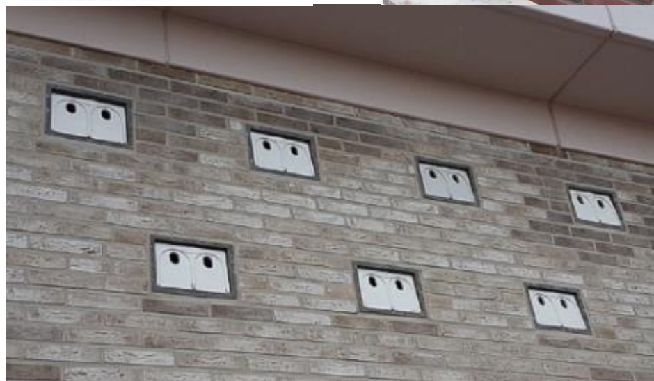
Le tunnel permet l'accès à la cavité à travers l'épaisseur d'isolation
