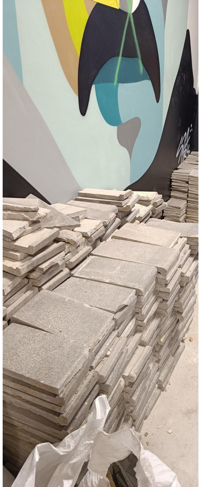
Photos du chantier : phase de démontage et stockage des éléments de réemploi
