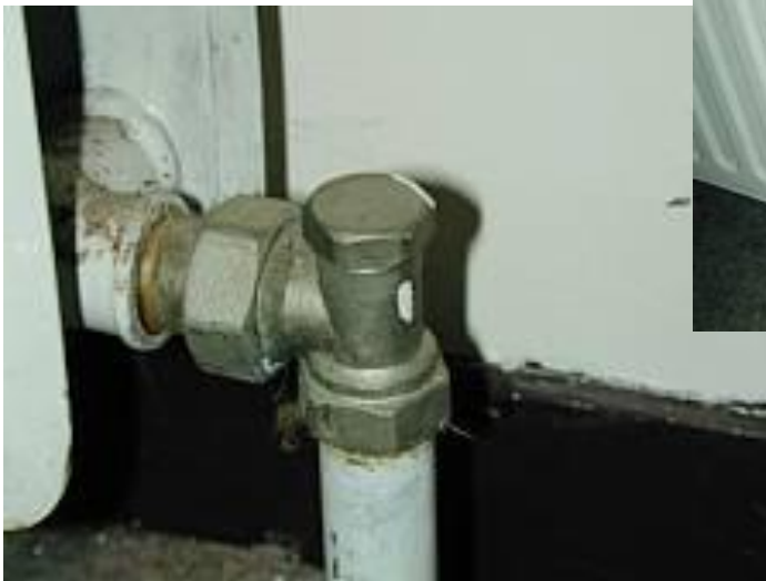
Té de réglage du débit d'un radiateur
