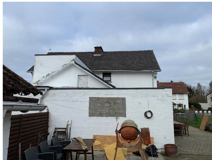
Peinture écaillée et éléments attachés
