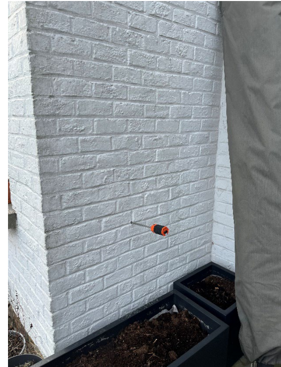
Brique de parement peinte avec une peinture étanche à la vapeur
