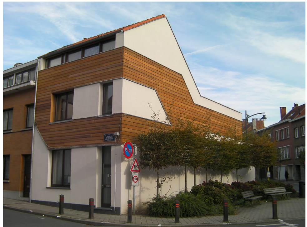
Façade à rue - APRES
