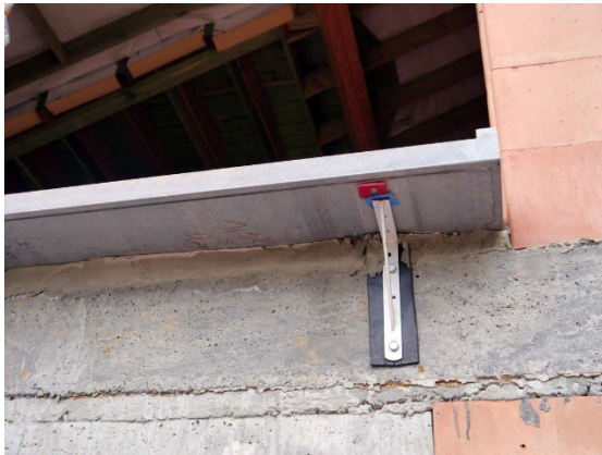
Coupure thermique seuil
