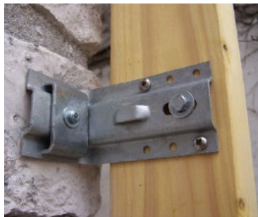
Métal traversant l'isolant
