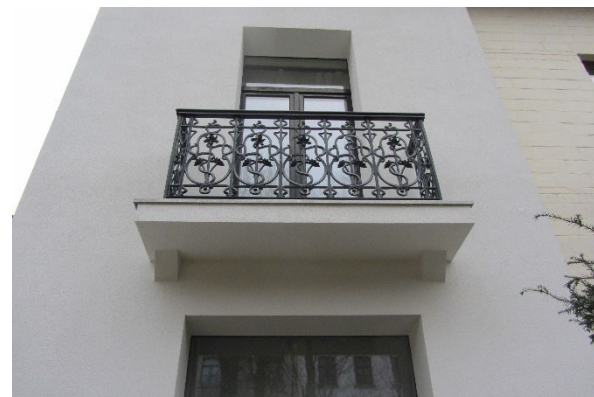
Façade avec balcon conservé - APRES
