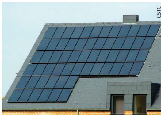
Fig. 10 Capteurs solaires photovoltaïques en semi-intégration.
