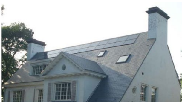
Figure 10: Modules intégrés - APERe
