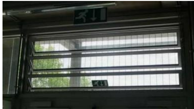
Protection des fenêtres contre l'intrusion
