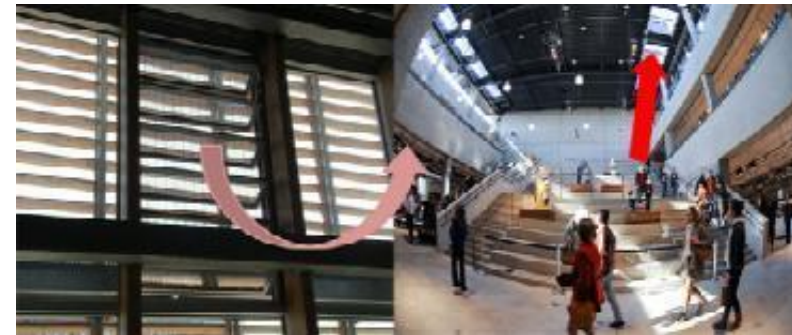
Grilles ouvrantes pour l'amenée d'air (gauche) et volets en hauteur pour l'évacuation de l'air (droite)
