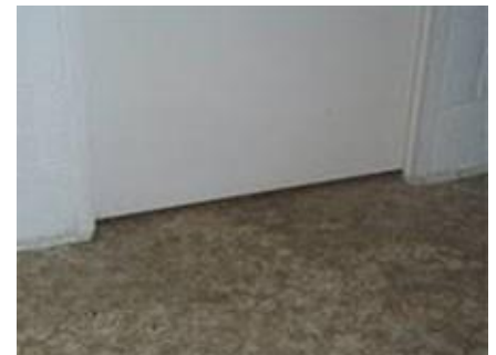
Porte détalonnée H_{\text{fente}} \geq 5 \text{ mm}
