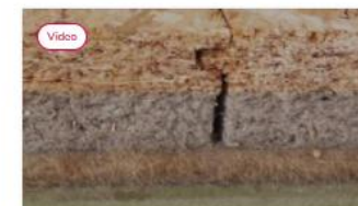
Rue de l'Est : Acoustique
