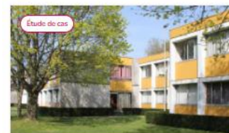
Rénovation de logements étudiants et réemploi - Projet Circular Retrofit Lab
