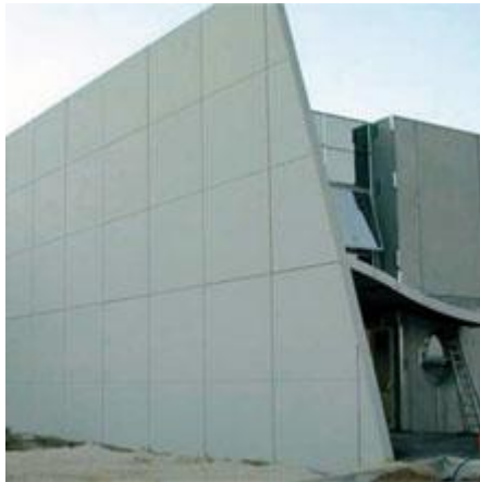
Voile béton armé
