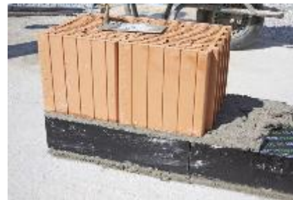
Bloc d'assise béton cellulaire/verre cellulaire
