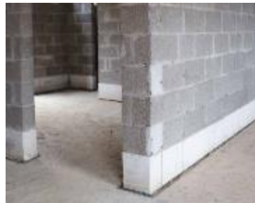
Bloc d'assise béton cellulaire/verre cellulaire
