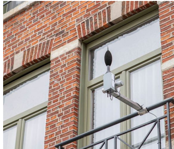
Immeuble existant (rénovation)
