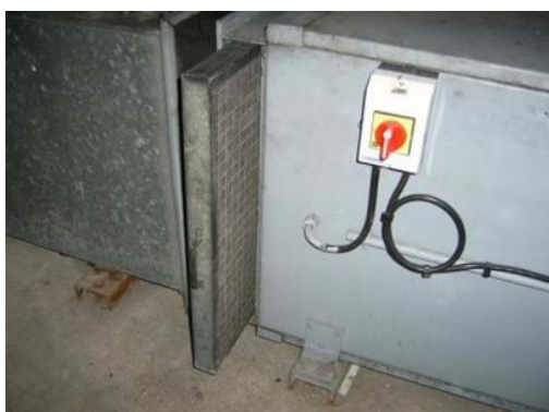
Figure 2.4 contrôle visuel d'un préfiltre
