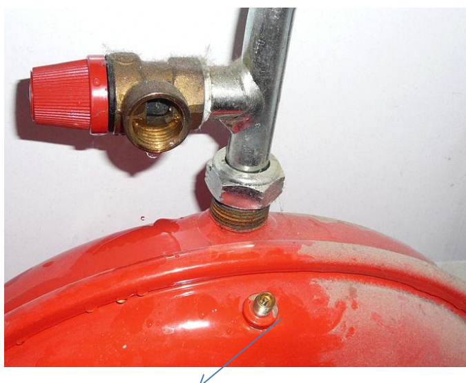
Figure 6.1 point de contrôle et de gonflage du vase d'expansion (après l'avoir « isolé » et avoir « supprimé » la contre-pression d'eau en le vidangeant)
