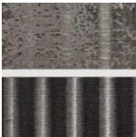
Figure 4.3 condenseur à air – avant et après nettoyage
