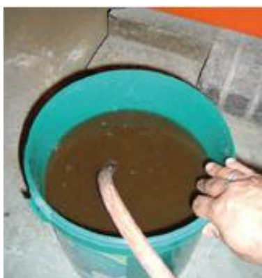
Figure 6.2 Exemple de dépôts recueillis en purgeant un séparateur de particules
