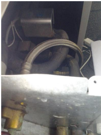
Figures 5.2 vanne 2 voies en amont de la batterie d'eau glacée d'un ventilo-convecteur et son élément de commande : le thermostat
