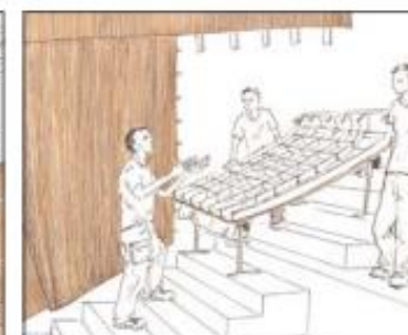
LES CAISSETTES PRÉFABRIQUÉES EN ATELIER SONT ENSUITE TRANSPORTÉES SUR LE CHANTIER OÙ ELLES SONT ASSEMBLÉES.
