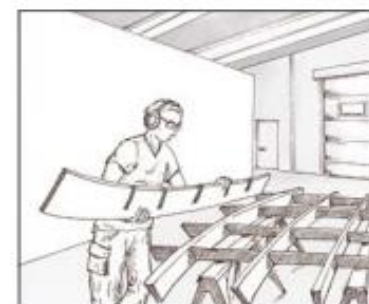
LE PLAFOND ACOUSTIQUE EST COMPOSÉ DE 135 CAISSETTES CONSTITUÉES D'UNE OSSATURE EN CONTREPLAQUÉ DE PEUPLIER IGNIFUGÉ ASSEMBLÉ À MI-BOIS, RECOUVERTE DE ROTIN.
