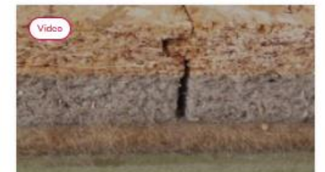
Rue de l'Est : Acoustique
