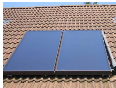
Capteurs plan vitrés
