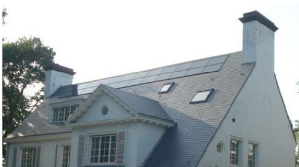
Figure 10: Modules intégrés - APERe
