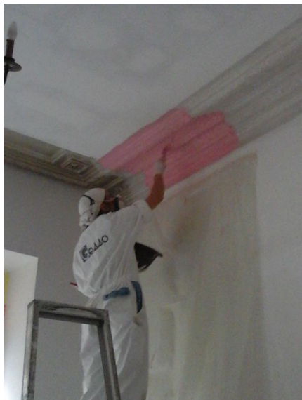
Réalisation d'un négatif de la moulure existante
