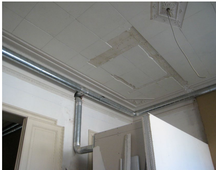
Installation des gaines de ventilation
