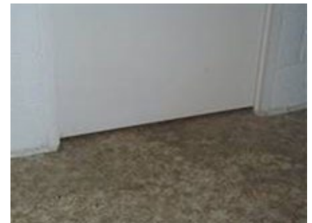
Porte détalonnée H_{fente} \geq 5 \text{ mm}
