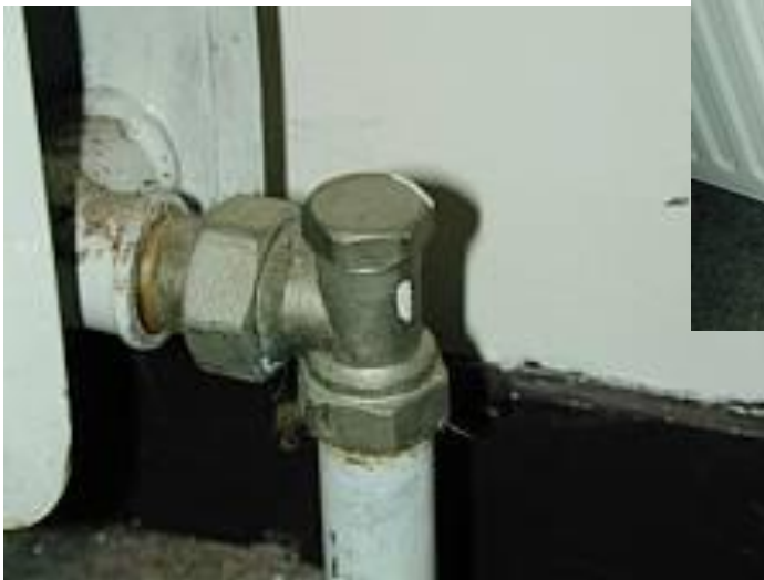
Té de réglage du débit d'un radiateur
