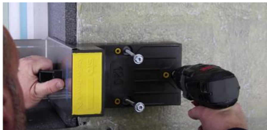
Fixation pour garde-corps
