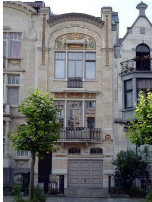
Façade à rue – APRES Isolée par l'intérieur
