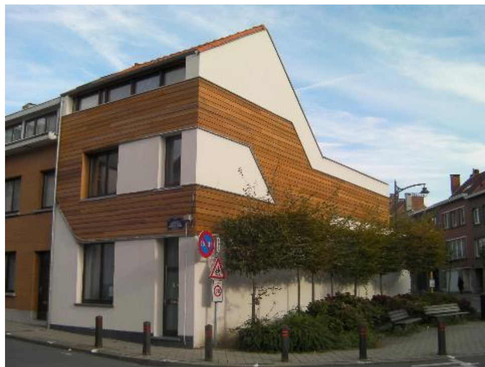
Façade à rue - APRES
