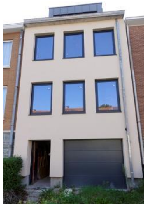
Façade à rue – APRES Isolée par l'extérieur
