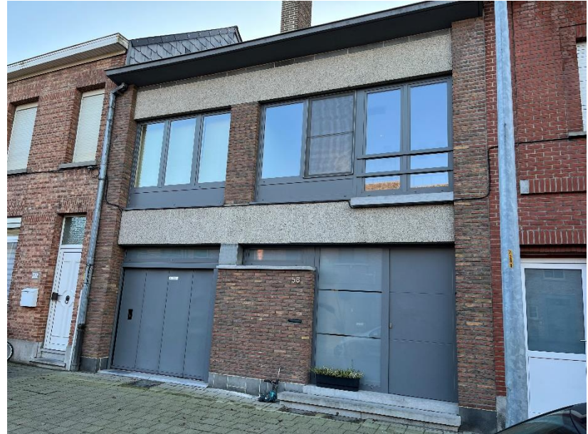
Façade sans (presque) aucun mur creux
