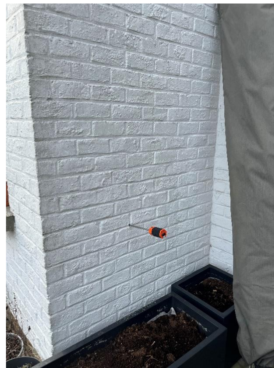
Brique de parement peinte avec une peinture étanche à la vapeur
