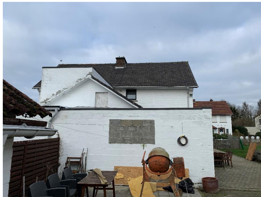
Peinture écaillée et éléments attachés
