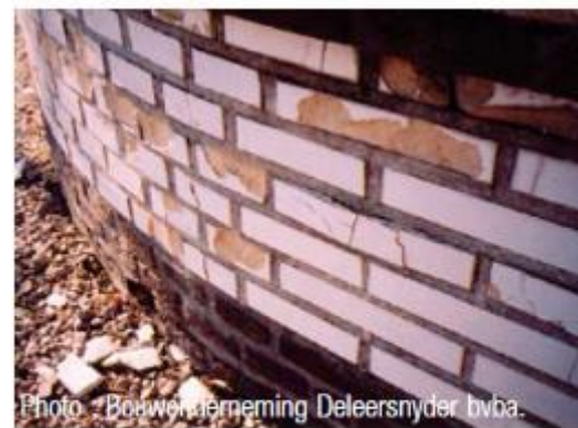
6 Finition de façade fermée à la diffusion de la vapeur d'eau. Gauche : carrelages céramiques. Droite : briques émaillées.
