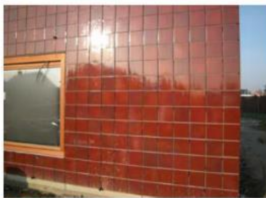
6 Finition de façade fermée à la diffusion de la vapeur d'eau. Gauche : carrelages céramiques. Droite : briques émaillées.
