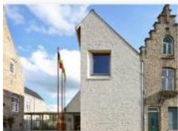
Façade en briques de la maison communale de L. Beninne
