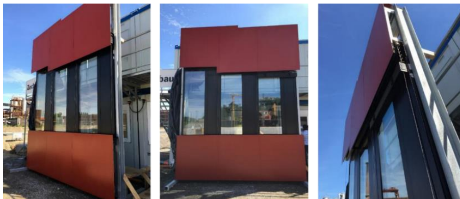
Système de façade modulaire et facilement remplaçable
