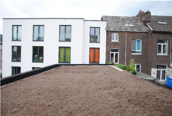
Source: écorce Toiture végétale du bureau écorce 30/08/2017
