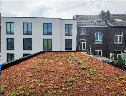
Source: écorce Toiture végétale du bureau écorce 22/06/2022
