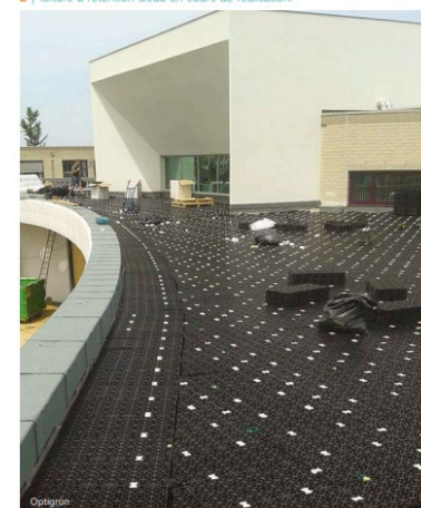
2 | Toiture à rétention d'eau en cours de réalisation.
