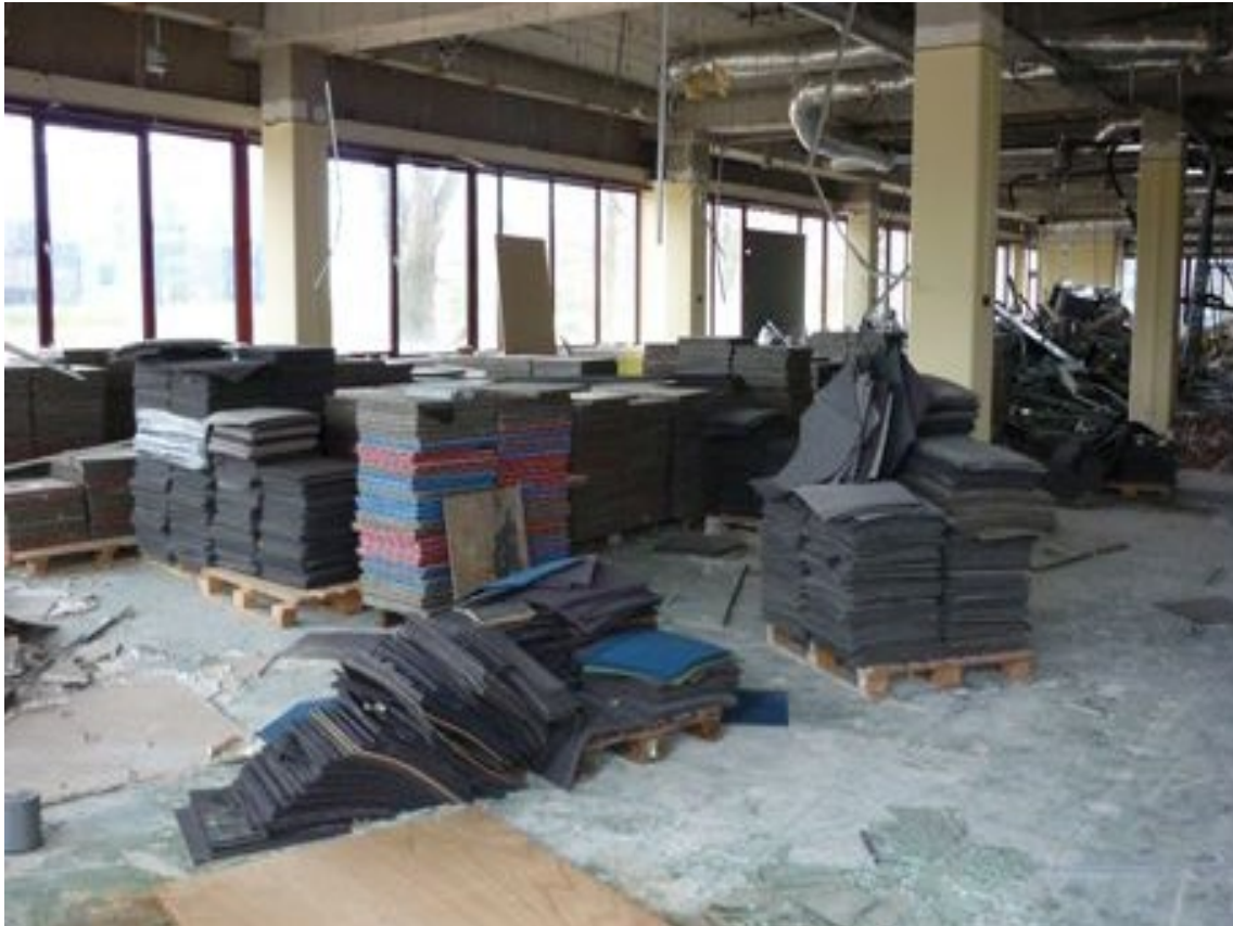
Déconstruction des éléments de seconde œuvre d'un immeuble de bureaux Source : CERAAsbl
