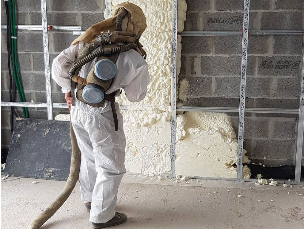
Protection intégrale lors de la mise en œuvre par projection d'un isolant thermique
