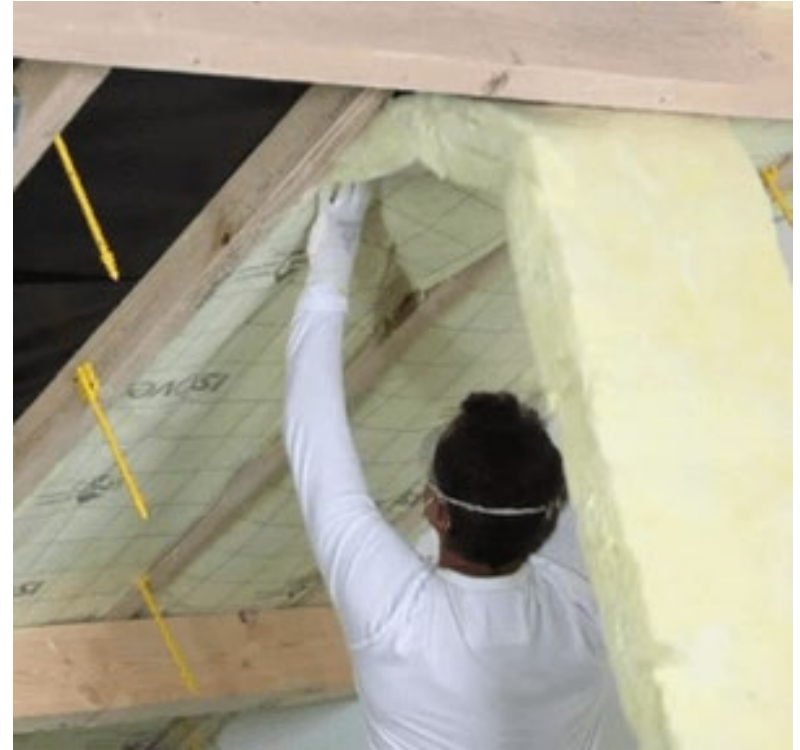
Port de gants lors de la manipulation d'une laine minérale, afin d'éviter l'irritation de la peau. Cette protection est complétée par un masque lors de la découpe et pose, afin d'éviter l'inhalation de fibres respirables
