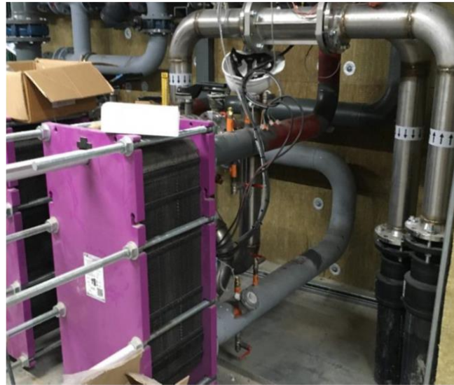
Echangeur à plaques géothermique
