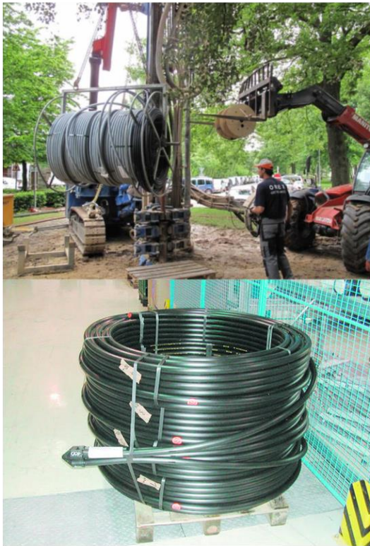
Forage & installation sonde PEHD
