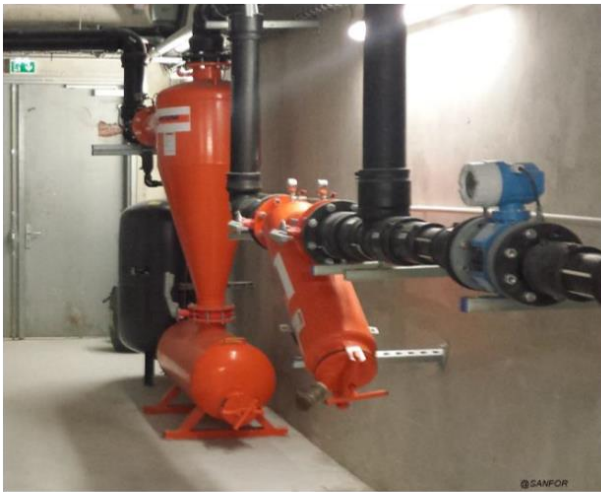
Filtre cyclonique et tamis (50 m 3 /h)
