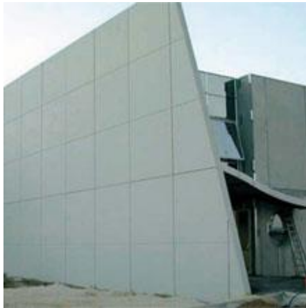
Voile béton armé
