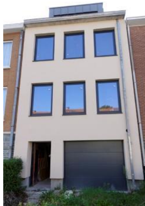
Façade à rue – APRES Isolée par l'extérieur
