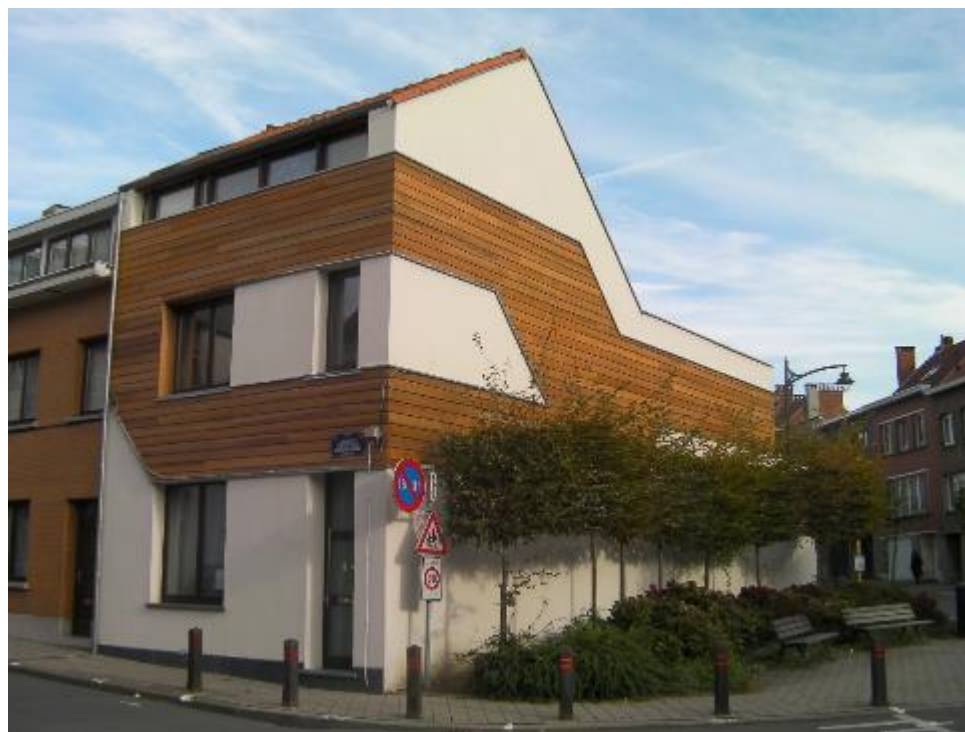
Façade à rue - APRES
