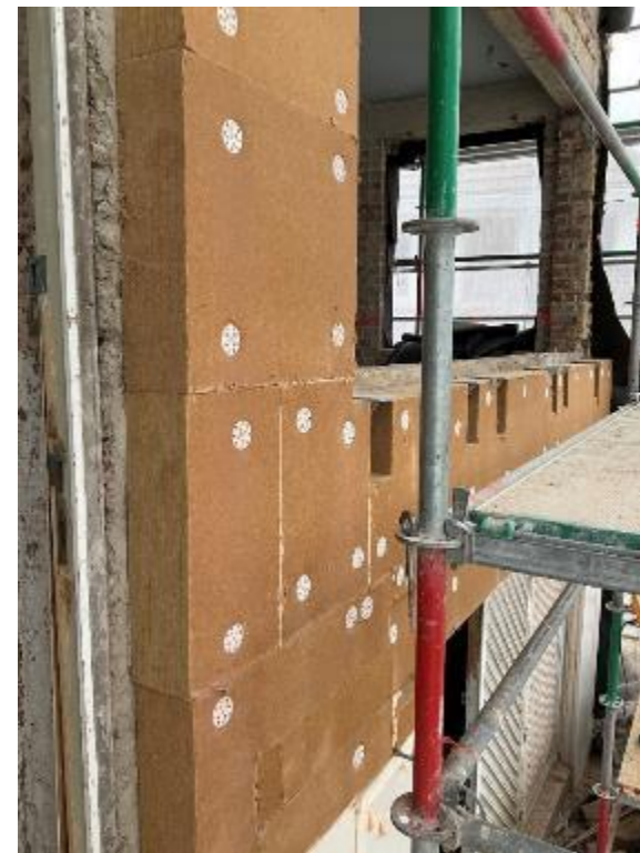
cornières à coupure thermique pour pierre-bleue
