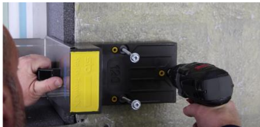
Fixation pour garde-corps
