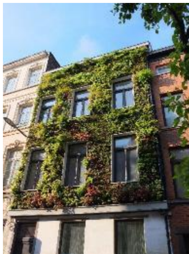
Façade à rue - APRES
