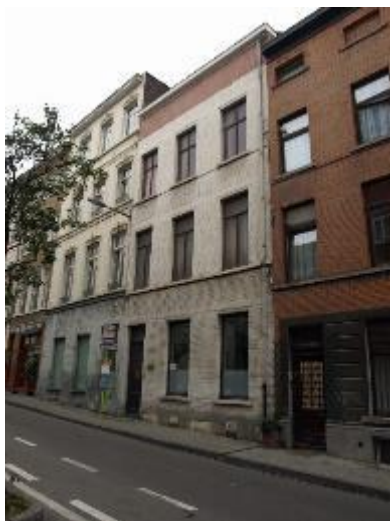
Façade à rue - AVANT
