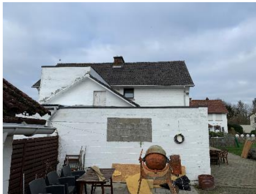
Peinture écaillée et éléments attachés
