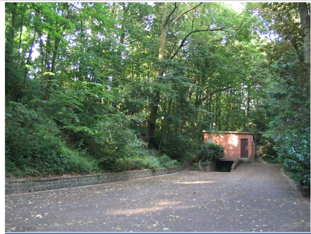
IB8_06. Le pavillon des gardiens du parc, bordé d'une large zone asphaltée (photo 2006, Aeolus)
