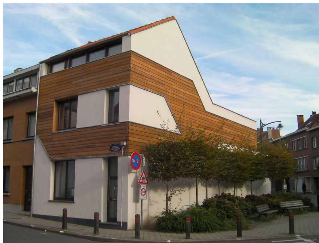
Façade à rue - APRES
