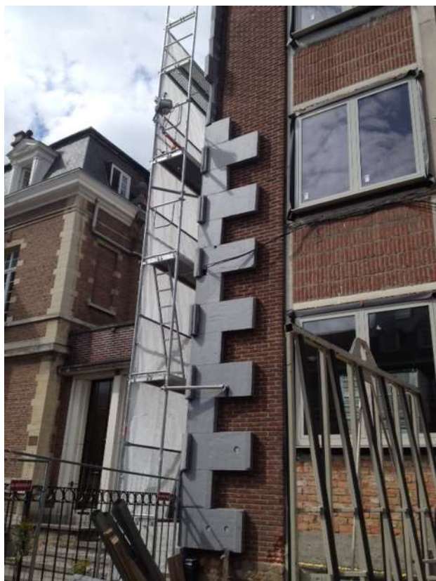
Façade à rue - AVANT
