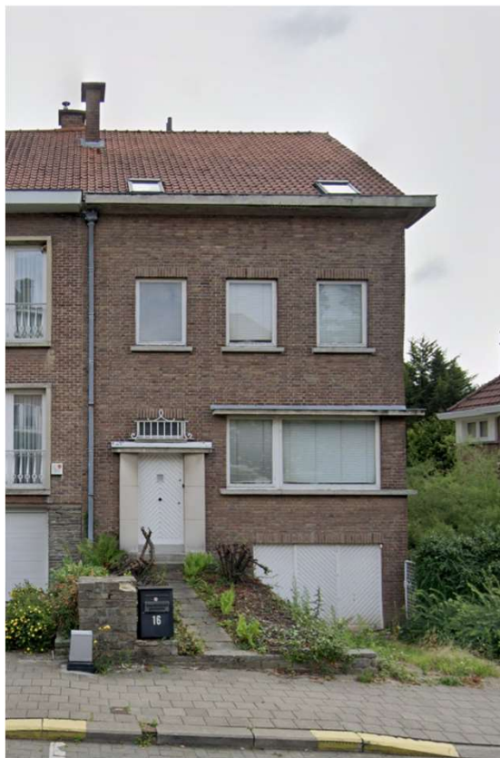
Façade à rue - AVANT
