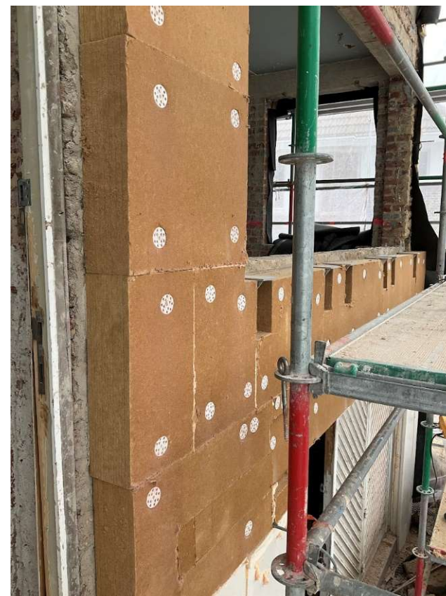
cornières à coupure thermique pour pierre-bleue
