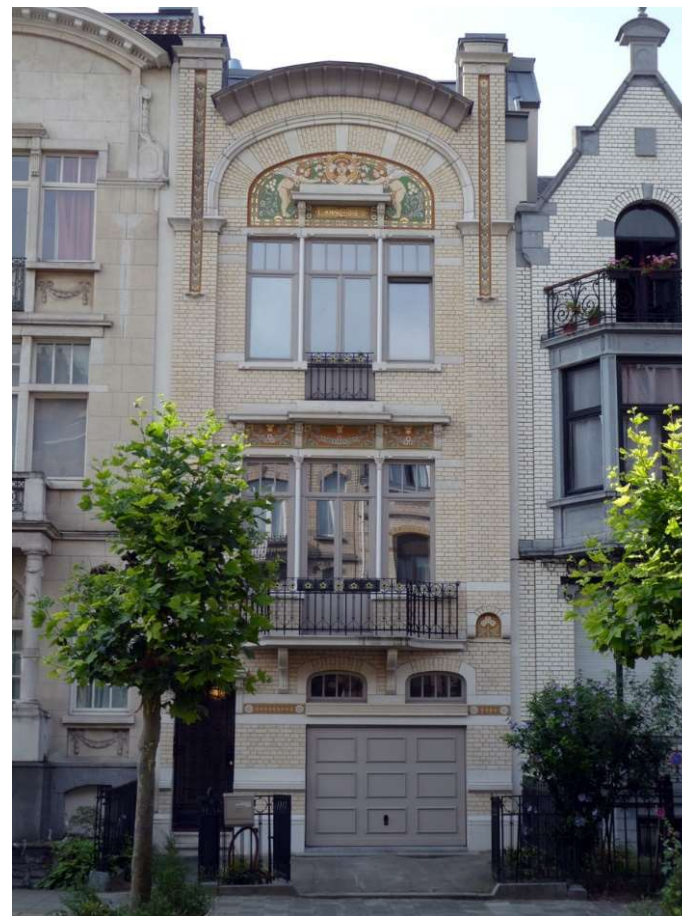
Façade à rue – APRES Isolée par l'intérieur
