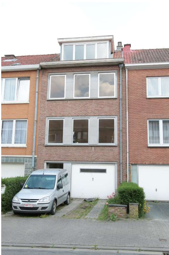
Façade à rue - AVANT
