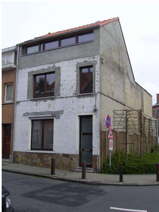
Façade à rue - AVANT
