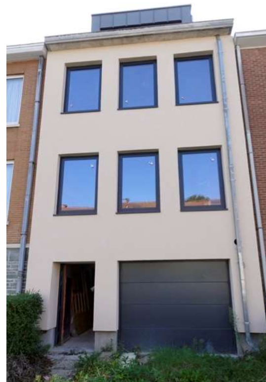
Façade à rue – APRES Isolée par l'extérieur
