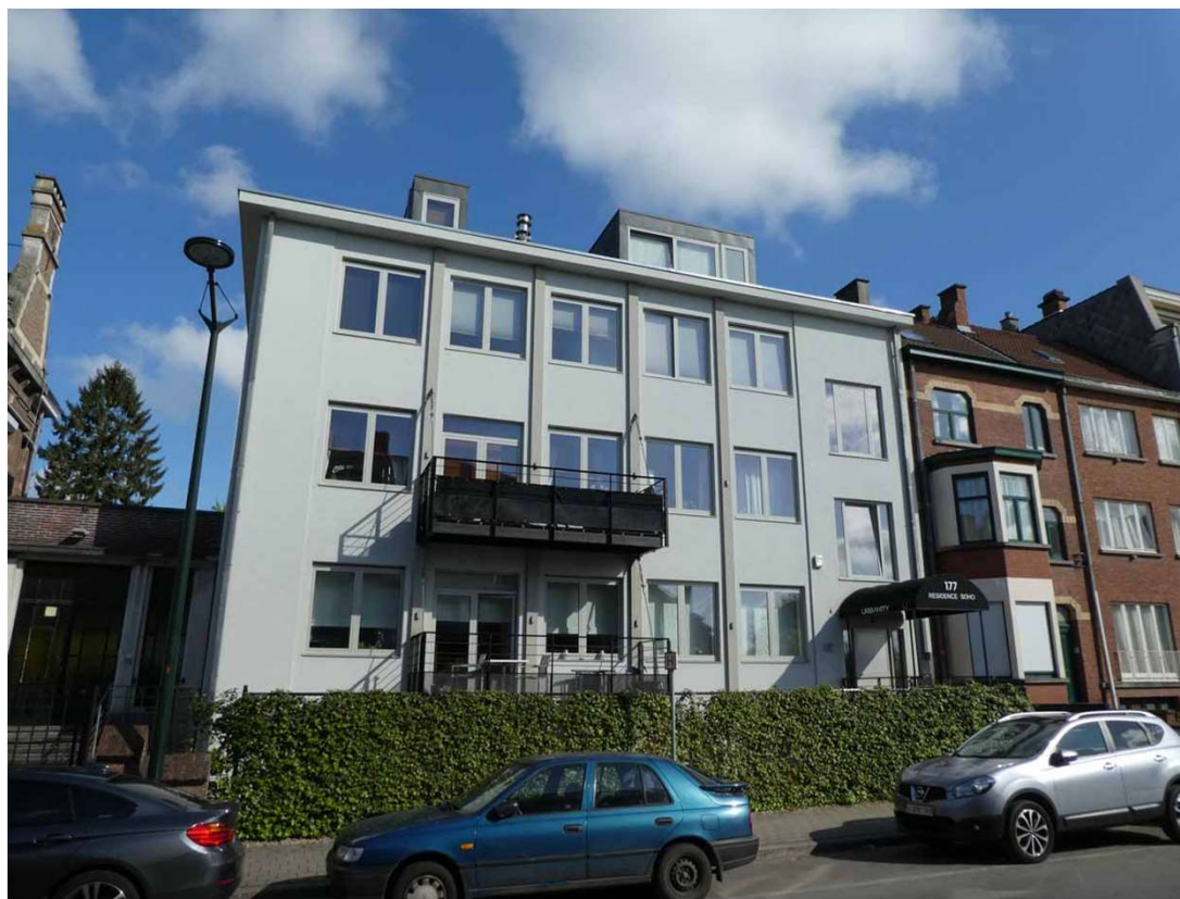
Façade à rue – APRES Isolée par l'extérieur
