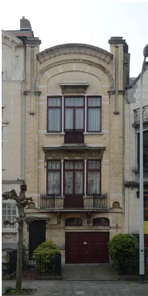
Façade à rue - AVANT
