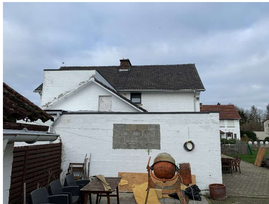
Peinture écaillée et éléments attachés
