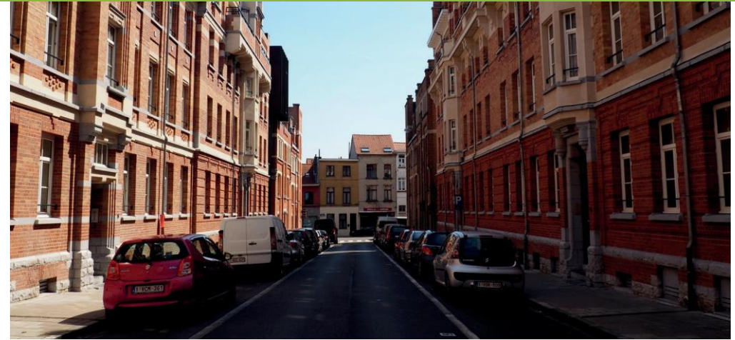
Rue Delbove : Ilot Central rénové - Ilot Boondael partiellement rénové
