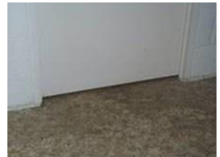
Porte détalonnée H_{\text{fente}} \geq 5 \text{ mm}
