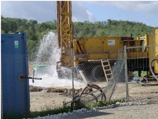
Forage du puits de production
