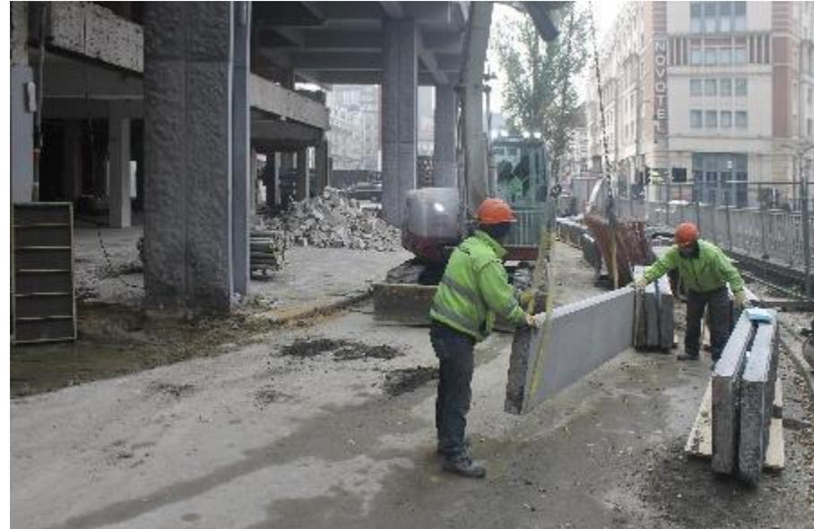
Démontage des blocs de pierre bleue de la façade de l'ancienne tour Philips, par l'entreprise en démolition, en vue de leur réemploi au sein du projet.
