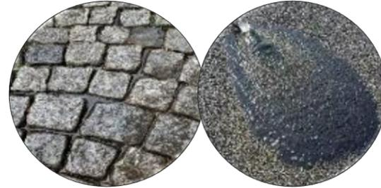
Pavés à joints perméables OU
