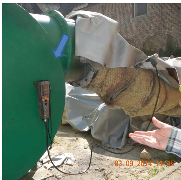
Mesure dans le conduit de rejet
