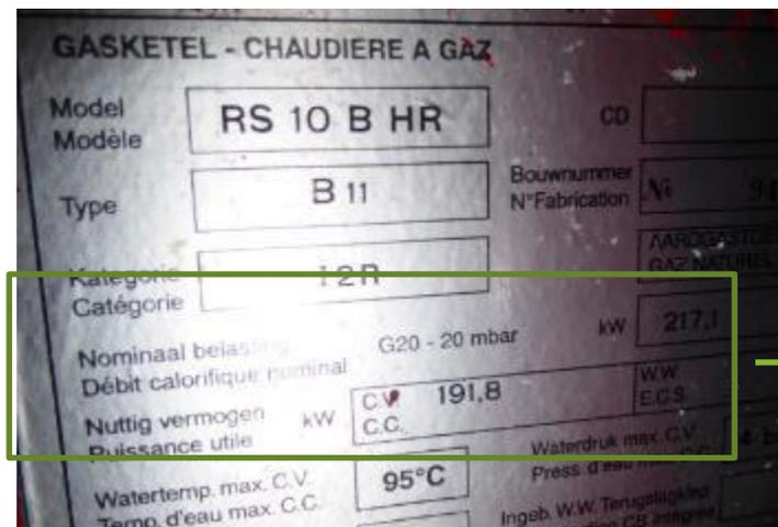
$$\begin{aligned} \text{Rend. utile (\%)} \\ &= 191,8 / 217,1 \\ &= 88 \% \end{aligned}$$
