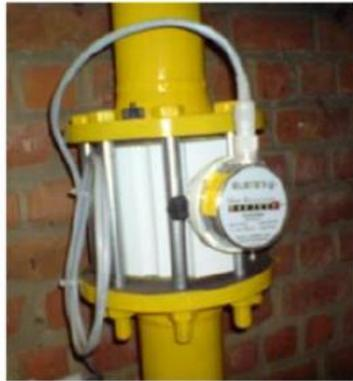
$\Sigma P \text{ chaudières} \geq 500 \text{ kW} \rightarrow$  compteur de combustible + compteur énergie
