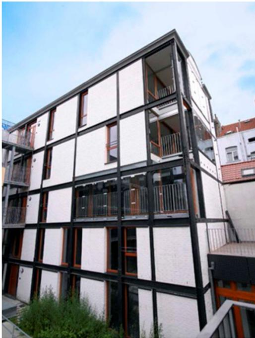
Exemple : [065] Savonnerie, réutilisation in situ d'une structure métallique existante.
