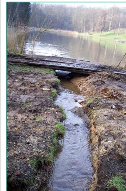
IA4\_13 : photo d'archive de 2002 des travaux de réaménagement du Vuylbeek (zones 1, 16 et 31) : la canalisation en béton du Vuylbeek est retirée
