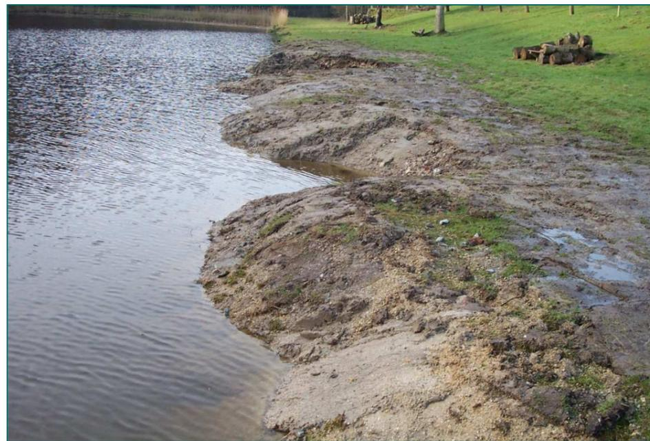
IA4\_12 : photo d'archive de 2002 des travaux de réaménagement de la rive de l'Étang des Silex (zones 1 et 17) : le soutènement en bois vient d'être retiré et la rive est aménagée en pente
