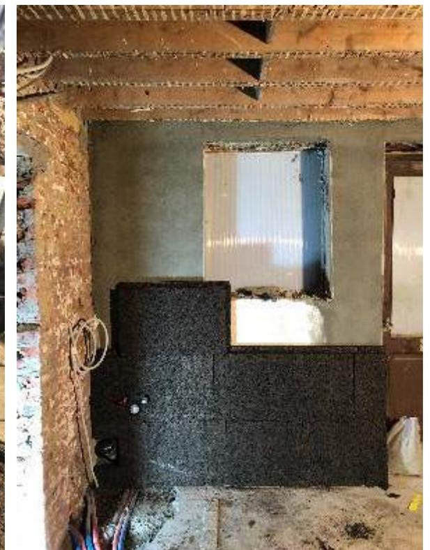
Le liège a été utilisé pour l'isolation de la cave et des toitures plates
