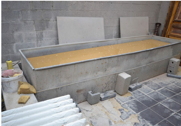
Préparation des radiateurs : Rova sprl
