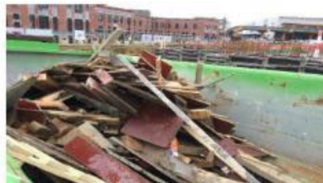
AVANT intervention du gardien de chantier
