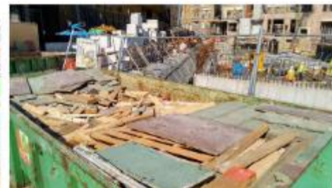
APRES intervention du gardien de chantier
